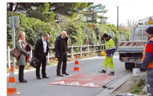
Pour renforcer la sécurité routière à Saint-Rémy, la commune a installé ces derniers mois 14 ralentisseurs sur les grands axes, aux entrées de ville. La plupart sont de type « coussin berlinois », qui obligent les conducteurs à lever le pied sans pour autant ralentir les véhicules de secours en cas d'urgence, d'autres sont
