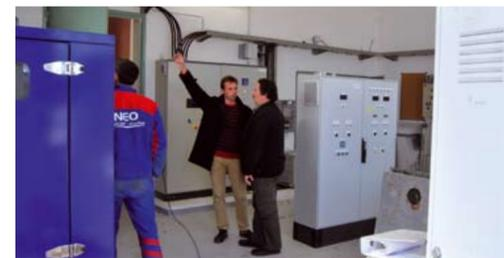
La Régie de l'eau et de l'assainissement, conjointement avec la Société des eaux de Marseille, a supervisé ces travaux, qui ont consisté principalement à mettre en place un puissant groupe électrogène de 90 kW. Son autonomie de 72 heures en pleine charge doit permettre, en cas de coupure importante d'électricité, de conti-
