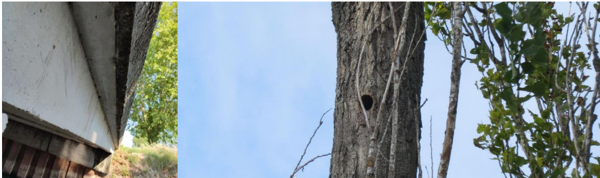
Figure 19. Ouvrage d'art sur la RD5 non favorable à la présence de chiroptères et Peuplier présentant un trou de pic (Naturalia environnement)
