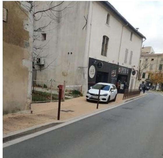
Point n°20 – Av. de la Libération, point dur PMR en cas de mobilier ou stationnement sur le trottoir.
